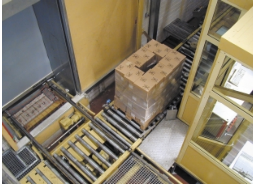
Foto R.1.5. Nach Verlassen der Kühlkanäle und Passieren von Rotationslichtschranke und i-Punkt gehts durch Schnelllauffore ins HRL. Förder- und Steuerungstechnik: SSI SCHÄFER NOELL
